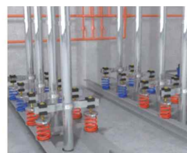
방진 스프링 설치 완료
