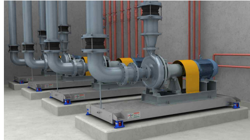
-펌프방진베이스 설치모습-KS B 1563(개방형)- -펌프방진베이스 설치모습-KS B 1563(밀폐형)-
