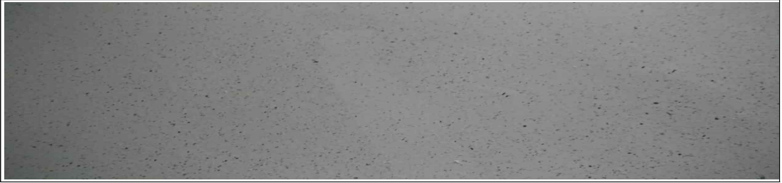
무늬코트 위 균열 보수 사진 (예시)
