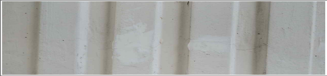
균열 보수 사진 (예시)
