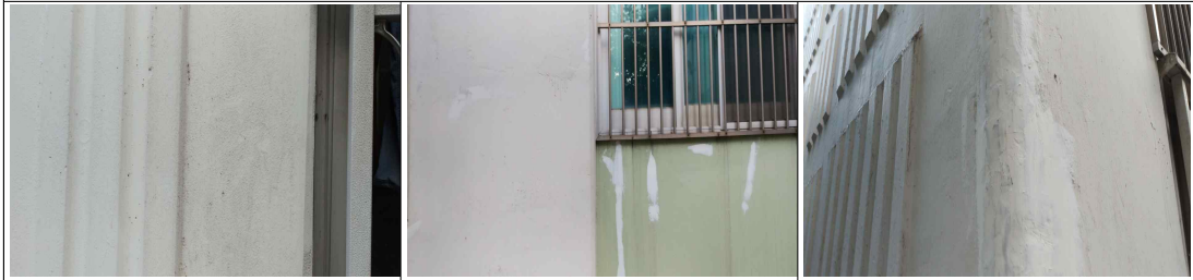
외벽 및 균열 보수 사진 (예시)
